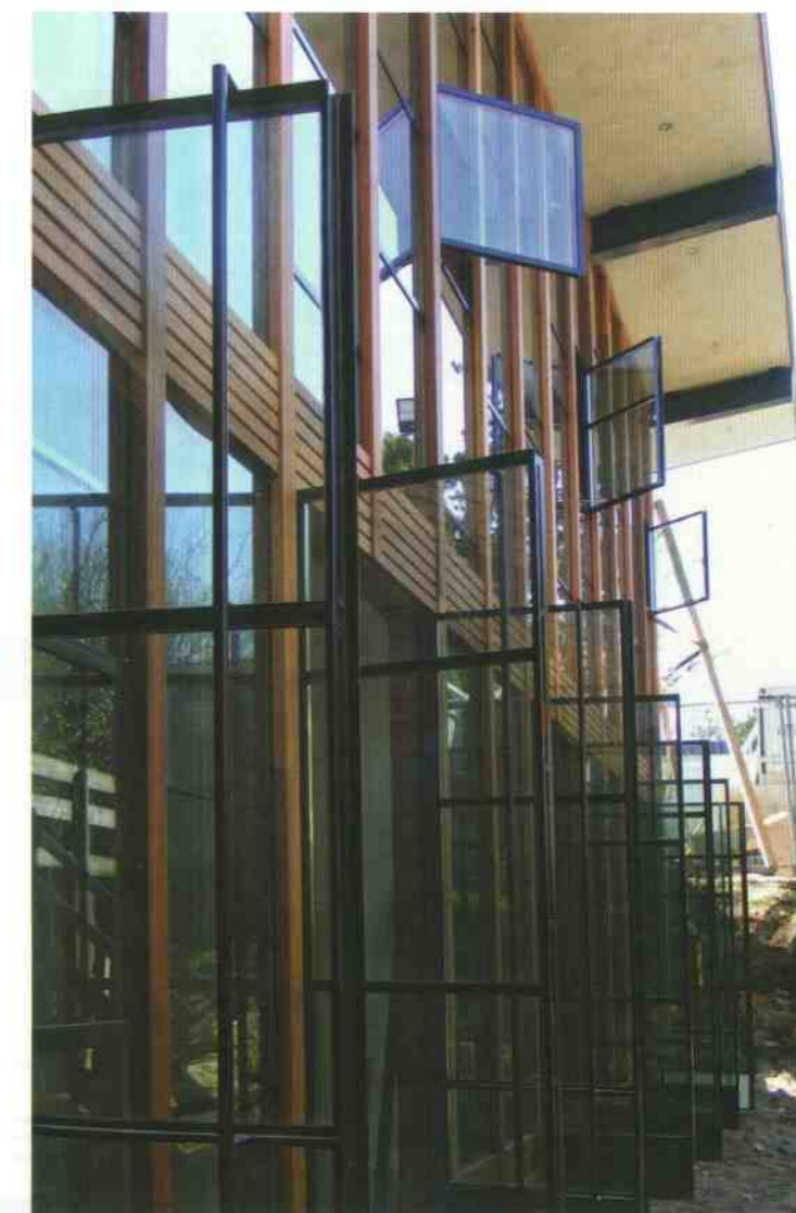
De gevel van de aanbouw bevat vele draaiende delen, dubbele deuren onder en kleine ramen boven
