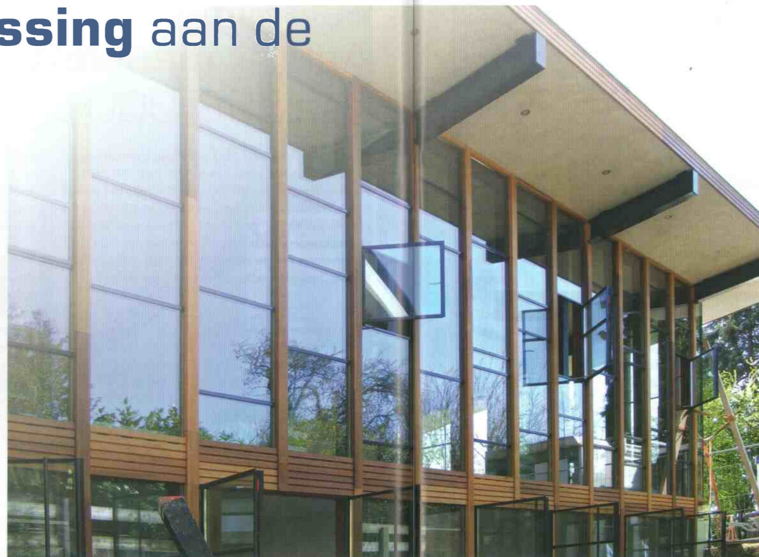
Vertikaal is er regelmaat in de gevel met de houten staanders, horizontaal niet met de stalen regels
